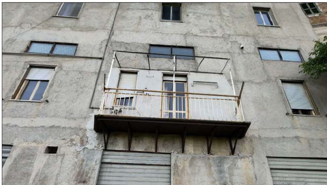
foto 11 - vista esterna del balcone con accesso dal soggiorno.
