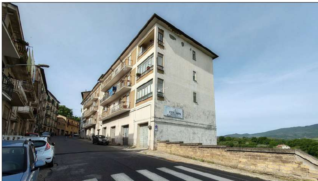
foto 1 - vista esterna d'edificio da via della Mola.
