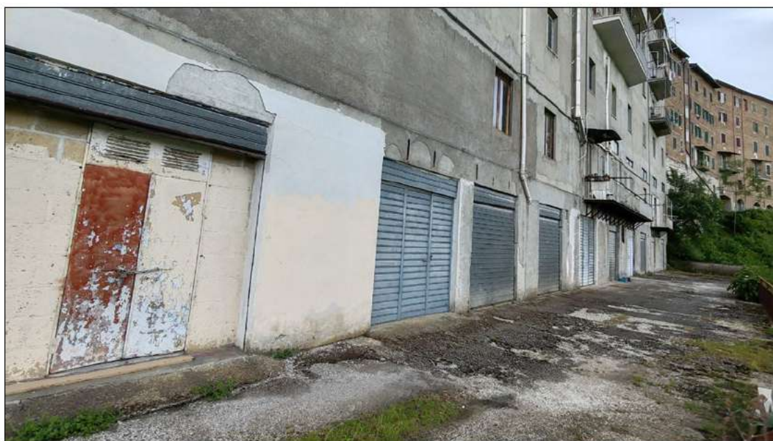
foto 2 - vista esterna dell'edificio da Nord-Ovest.
